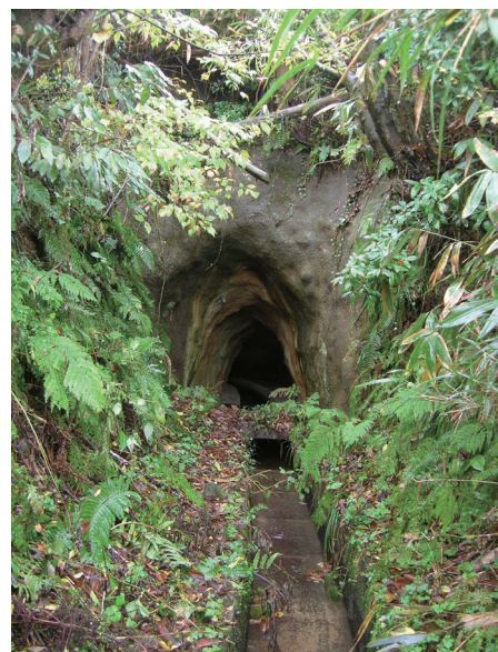
長柄用水 箕打トンネル入口
