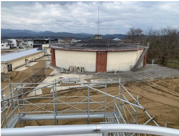
既存七塚配水池
