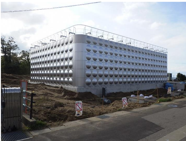
七塚配水池築造工事（その2）本体工事
