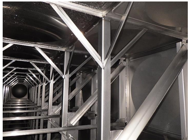
七塚配水池築造工事（その2）本体工事内部
