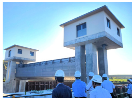
河北潟放水路防潮水門を現場視察
