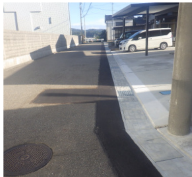
側溝改修(着工後)
