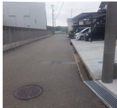
側溝改修(着工前)
