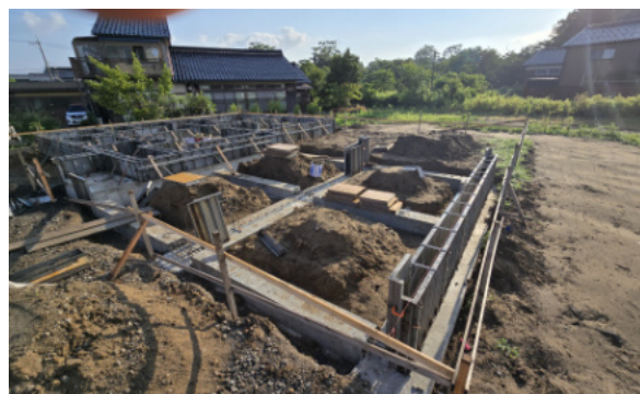
中沼地区の新築住宅の基礎工事
