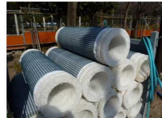
写真 -2 ドレーン管 (挿入前、立体網目状集排水管に透水シート、ジオテキスタイルを巻いた状況)
