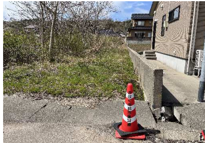
図 エリアA 民家隣接状況写真
