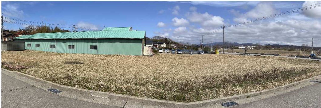
図 地盤改良工法エリアB 全景写真
