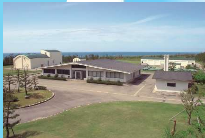
北部浄化センター
