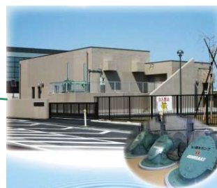
内日角雨水ポンプ場
