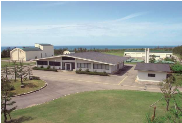
廃止予定の北部浄化センター
