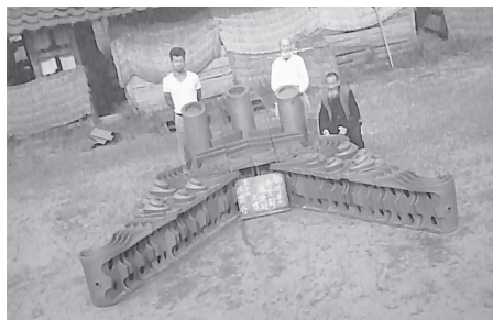
写真8 夏粟で作り中沼で焼いた鬼瓦 【昭和35年（1960）頃】
