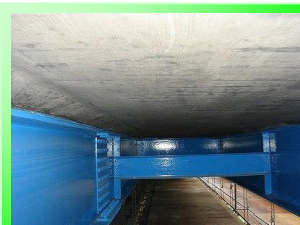
コンクリートの補修
