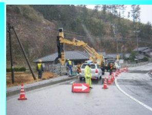
橋梁点検車による定期点検
