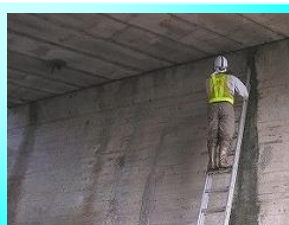
梯子による定期点検
