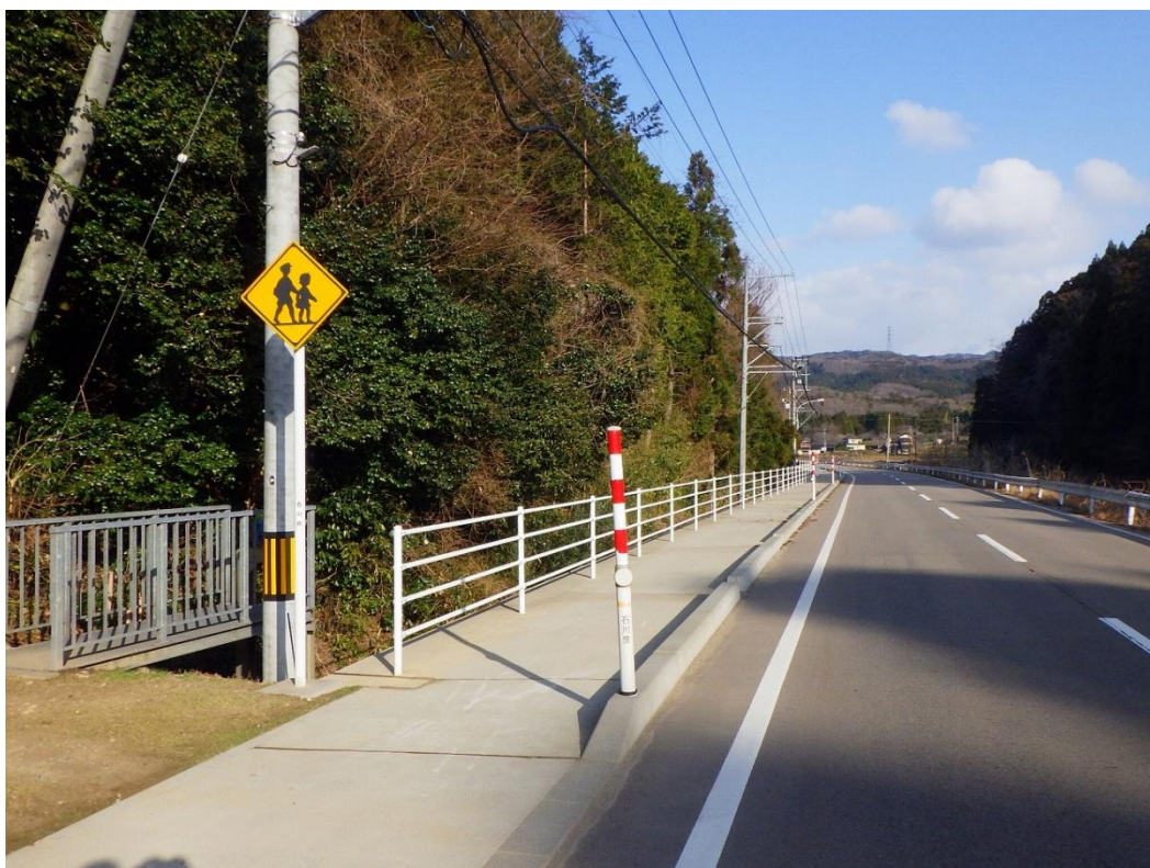
県道八野高松線(瀬戸町地内)の歩道整備状況
