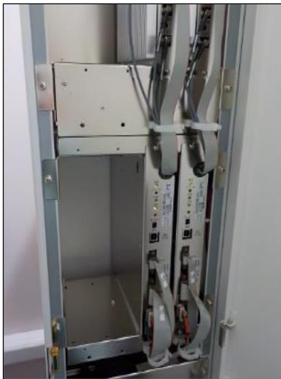
【防災行政無線送受信装置 及び電源装置】
