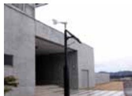
小・中学校に避難誘導灯を整備
