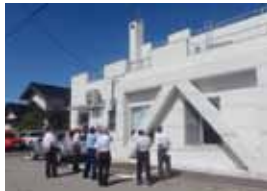
高松分署耐震補強工事
