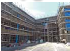
外日角小学校改修
