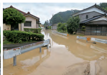
多田川の氾濫により冠水した道路
