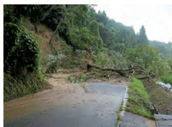
土砂崩れにより寸断された道路
