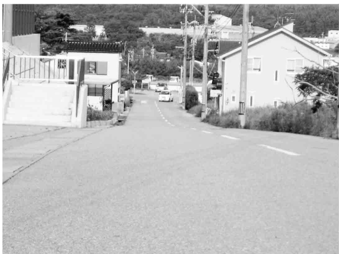
消雪工事が待たれる路線（浜北地区）
