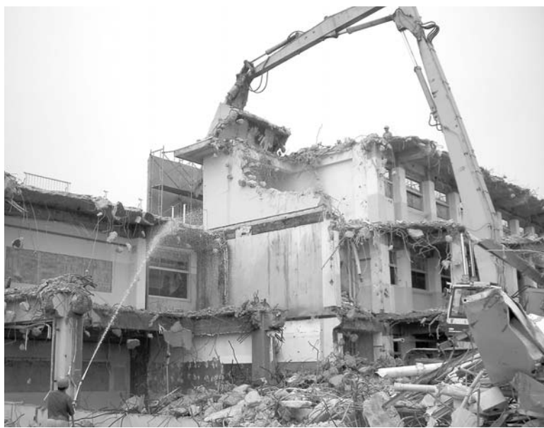
解体される校舎
