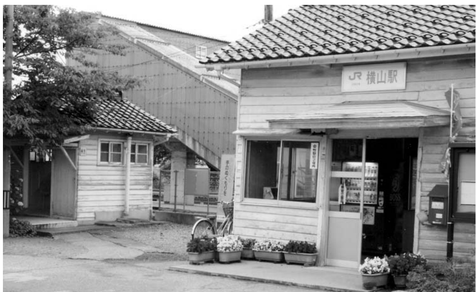
老朽化した横山駅舎
