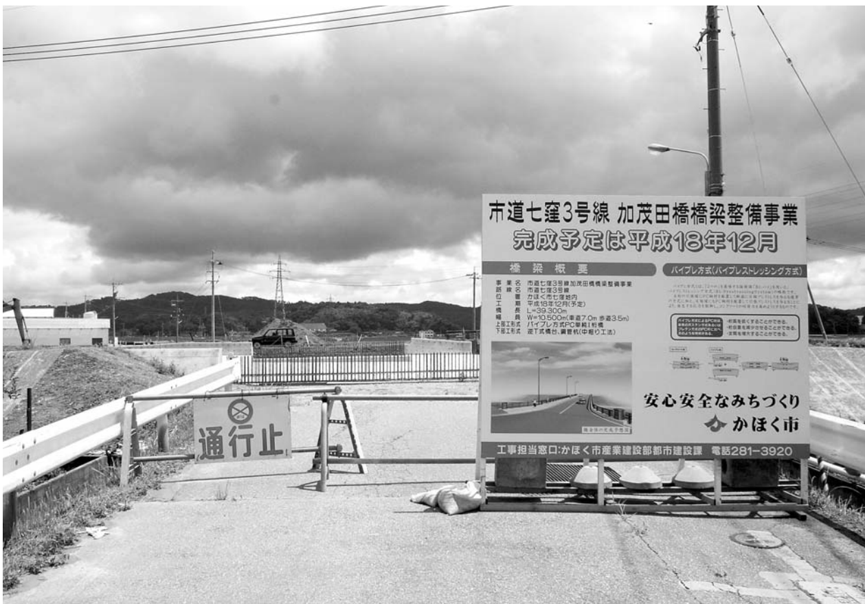
完成間近の加茂田橋
