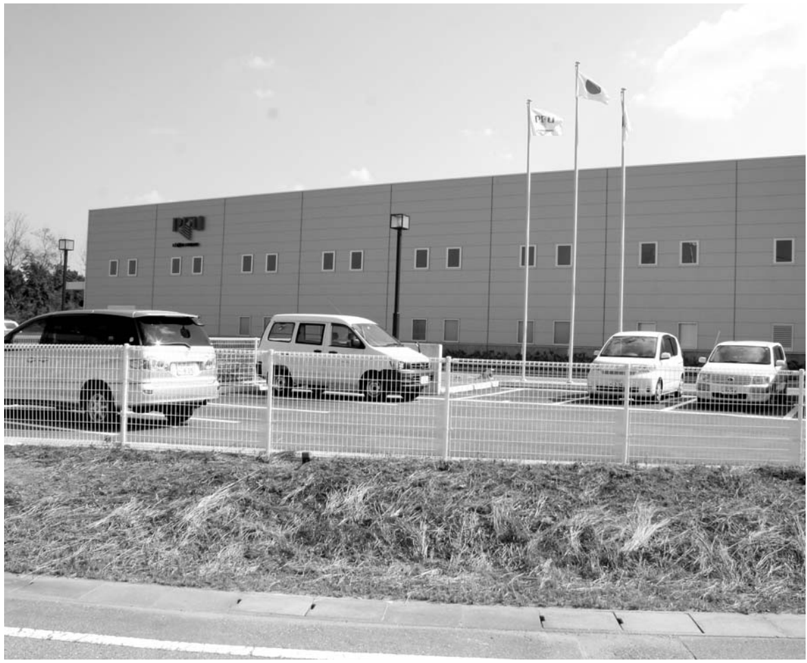
高松工業団地に建設
