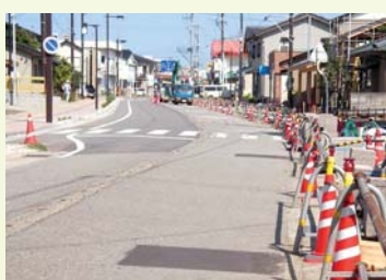
宇野気駅前通りの拡幅工事
