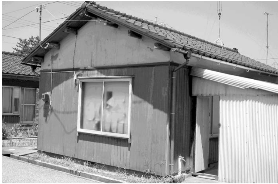
解体予定の市営住宅
