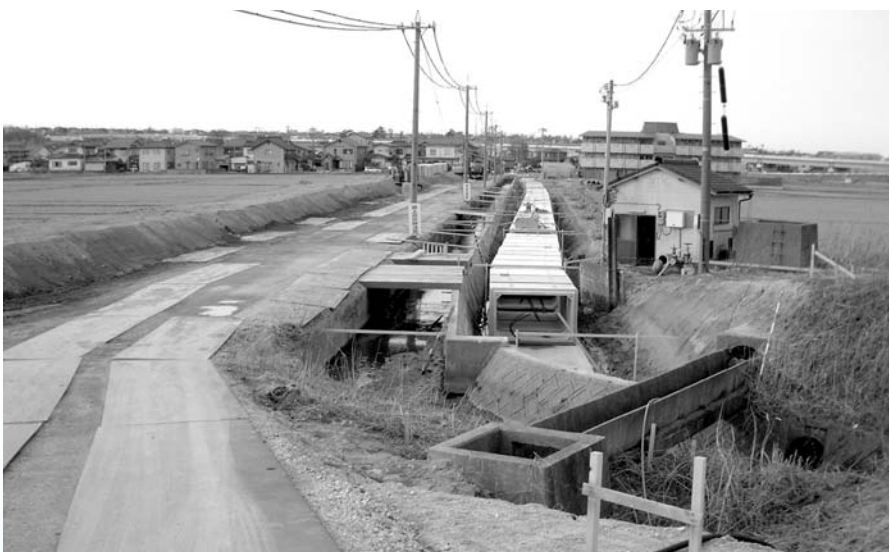
雨水幹線整備工事（イオン計画地）
