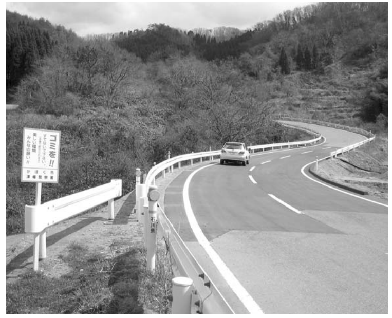
復旧された北部農免道路(余地・上大田間)
