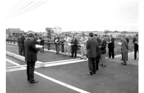
加茂田橋の完成
