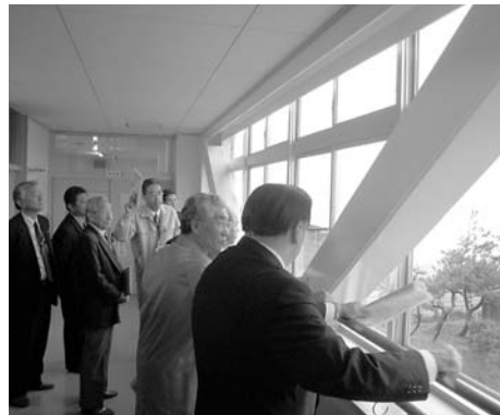
七塚小学校耐震工事
