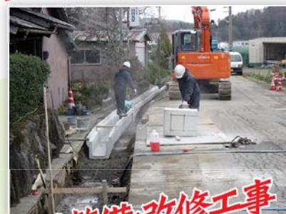
側溝整備・改修工事 の中断
