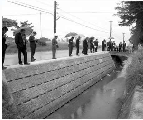
豪雨災害復旧（多田地内）
