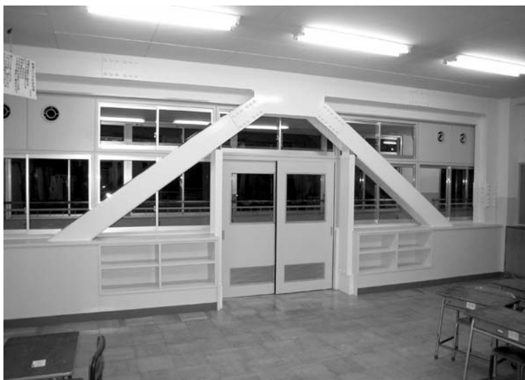
七塚小学校耐震工事完成
