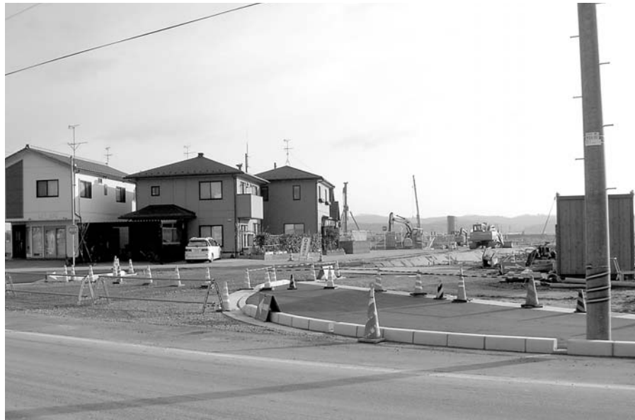
大型商業施設周辺の道路整備 (内日角地内)
