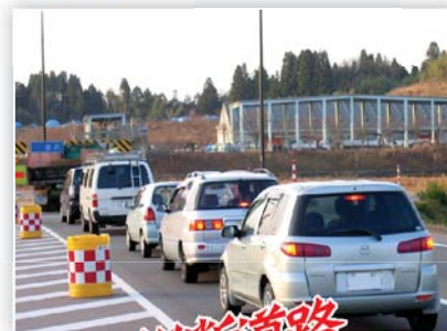
河北縦断道路 道路建設の中断
