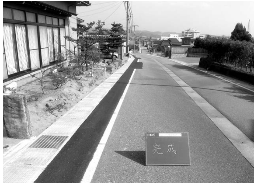
側溝改修工事 (秋浜地内)
