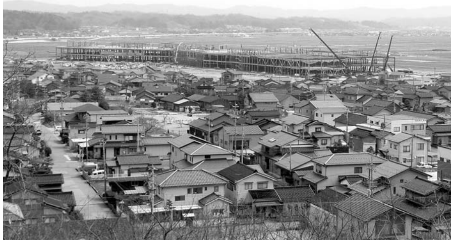
大型商業施設の建設現場
