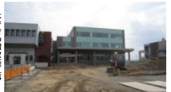
本庁舎の増改修工事
