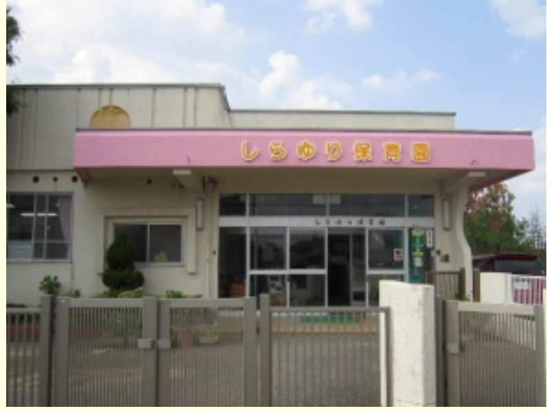
保育園建設事業に着手(白尾地内)
