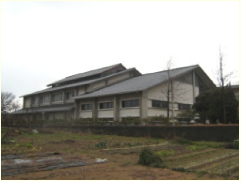
耐震補強・大規模改修工事を行なう新化館
