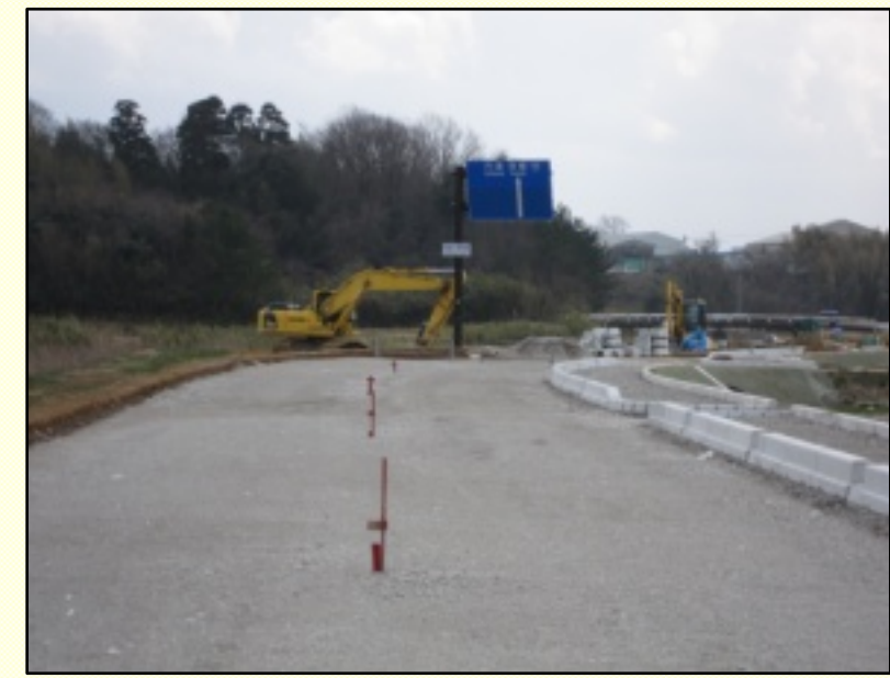
完成間近かな市道23号線(宇気地内)
