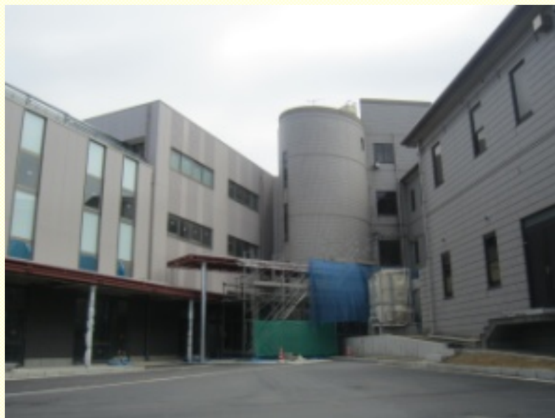
6月供用開始予定の高松多目的施設(仮称)の増築部分(左側)
