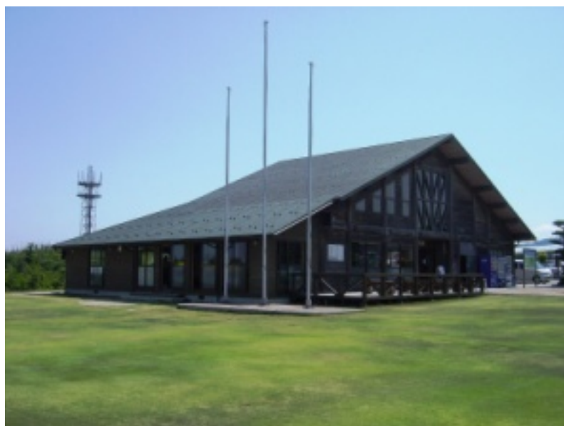
改修前の高松グラウンド・ゴルフ場クラブハウス
