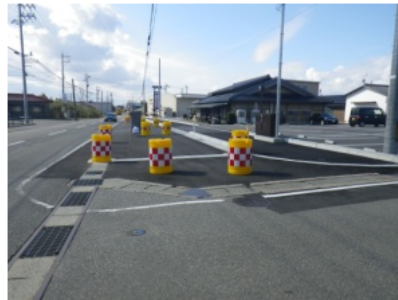
国道159号線の自歩道整備状況
