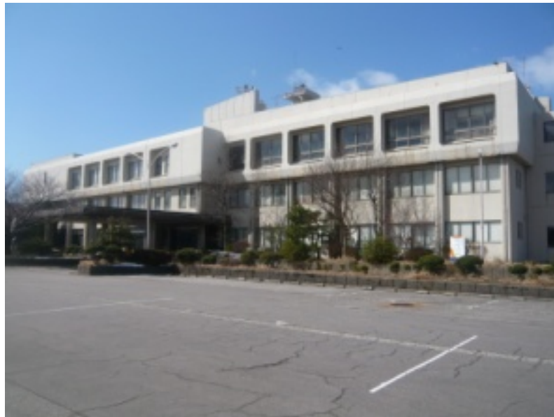
解体される旧七塚庁舎
