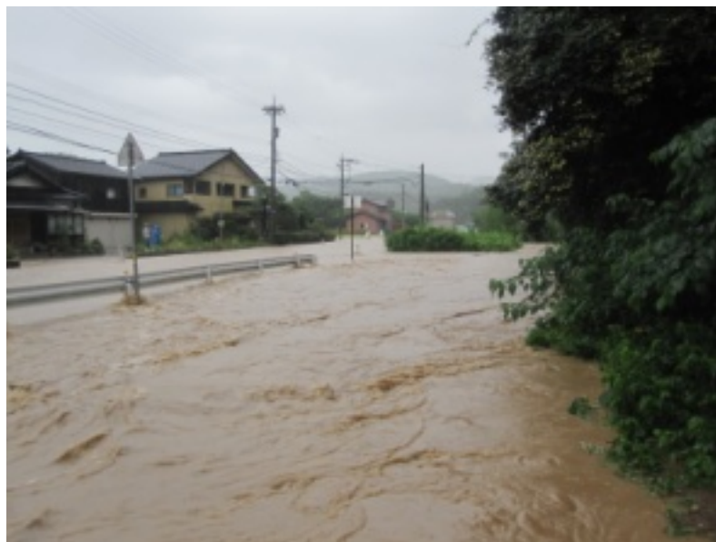
橋が見えないくらいの氾濫（宇ノ気川上流部）
