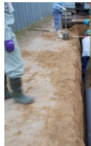
耐震化を進める水道管
