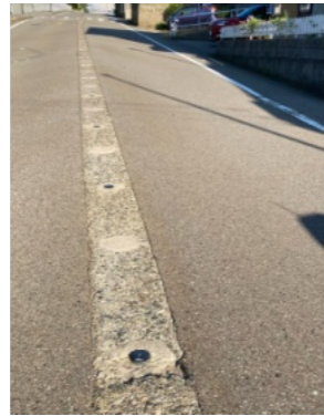
消雪パイプ装置
