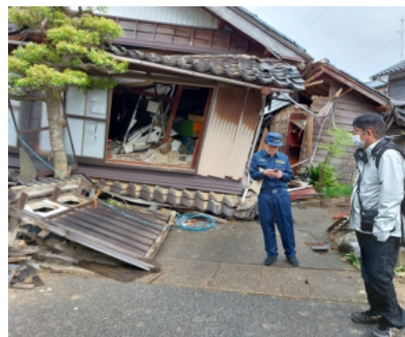
地震により壊れた住宅
