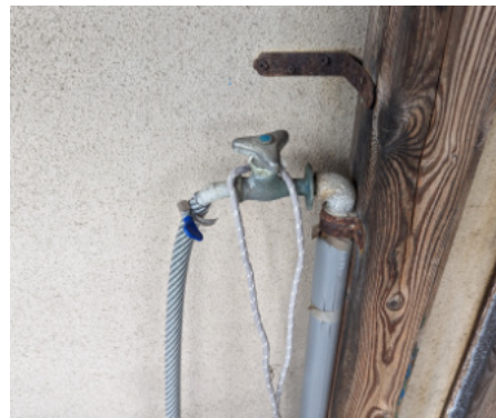
水道管の凍結防止工事
