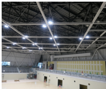
総合体育館(建設中)のLED照明
