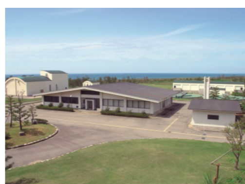
廃止予定の北部浄化センター
