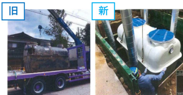
合併処理浄化槽の取り替え
